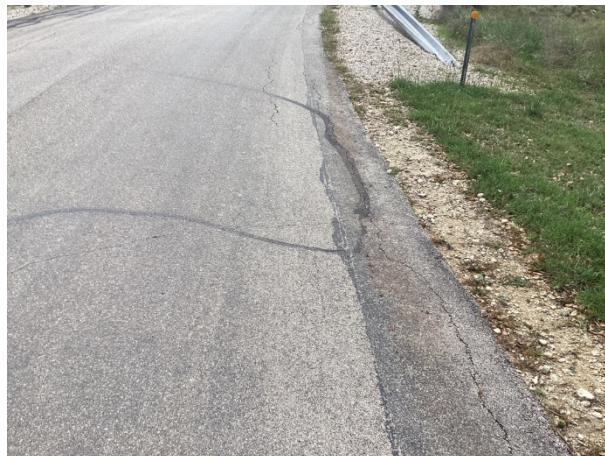
Edge cracks
