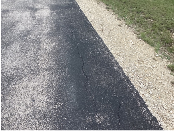
Edge cracks
